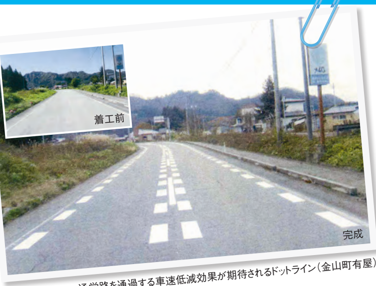
通学路を通過する車速低減効果が期待されるドットライン(金山町有屋)
