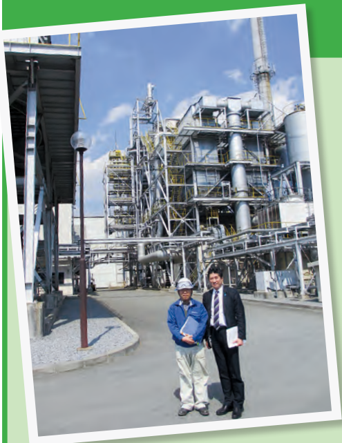
発電出力12,000kWの木質チップ発電所 (大分県日田市・株田ウッドパワー)
